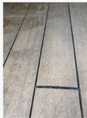
คราบที่ไม่ได้รับการทำความสะอาดอย่างเหมาะสม
